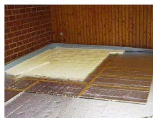
Sl. 7. Primjena VIP-a u podu na tlu sa razvodom grijanja i ostalim neophodnim rasporedom slojeva, izvor: Pär Johansson, Report in Building Physics , Gothenburg: Civil and Environmental Engineering, 2012, str.11
