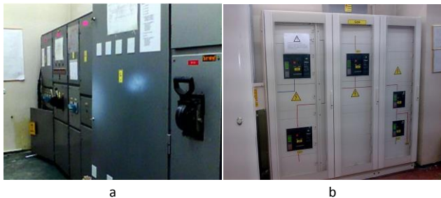
Sl.2 Niskonaponski razvod juče a. i danas b.
