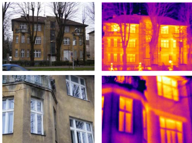
Sl.3. Termogrami činovničkog paviljona. Izvor: dokumentacija naučno-istraživačkog projekta „Tipologija stambenih zgrada Bosne i Hercegovine“
