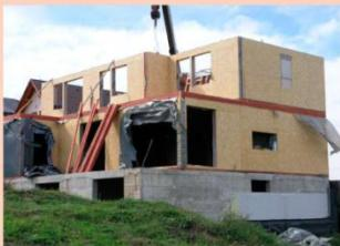
Vrlo niskoenergetska kuća M6 (arhitekt prof. Ljubomir Milčević) drevne i betonske konstrukcije u Gornjem Stupniku, Hrvatska, u izgradnji
