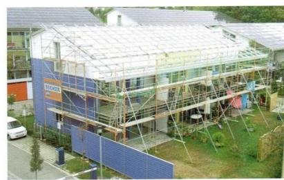
**Slika 155:** Krov s pokrovom od sunčanih modula ne treba klasičan pokrov (lijev). Moduli su montirani na potkonstrukciju iznad sekundarnog pokrova, Schlierberg, Freiburg, Njemačka.
