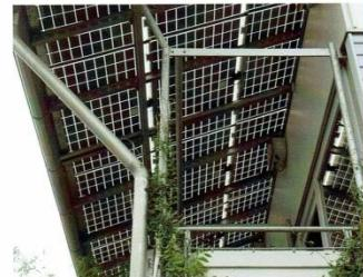
**Slika 154:** Sunčani moduli i ispravljači za pretvaranje istosmjernog u izmjenični napon, Schlierberg, Freiburg, Njemačka
