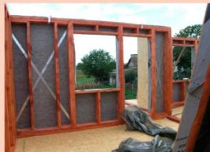
Detalj izolacije drevnog zida vrlo niskoenergetske kuće drevne i betonske konstrukcije u Gornjem Stupniku, Hrvatska
