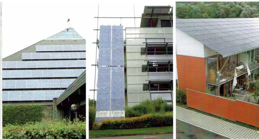
**Slika 157:** Sunčane elektrane na krovu crkve, pročelju tvornice sunčanih pretvornika, na krovu stambenog naselja (gorje), Freiburg, Njemačka
