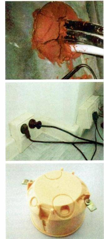
**Slika 121:** Ugradnja elektroinstalacijskih razvodnih kutija: brtvljenje proboci (gore), dodana kutija (sredina), zrakonepropusna zidna ugrađena kutija (dolje).
